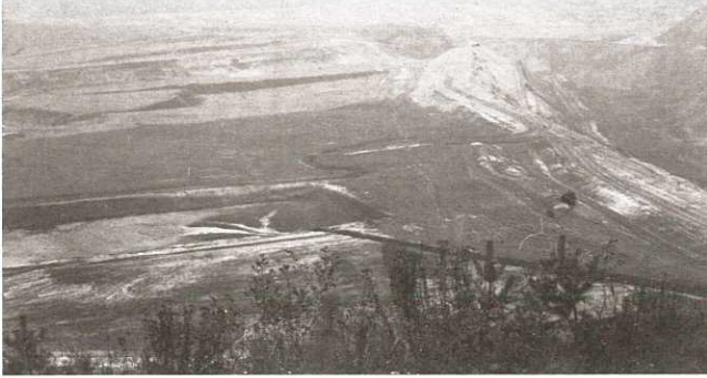
Abb. 1: Haldenbegrünung zum Erosionsschutz
